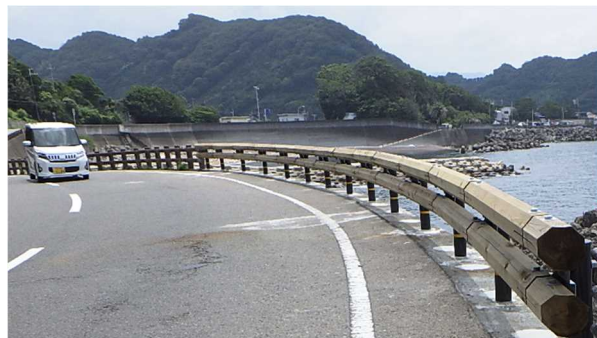
② 木製Gr[有田郡湯浅町 県道 有田湯浅線] 約 15百万円 (約 2百万円) 施工延長 205m
