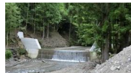
小井谷地区 治山堰堤 神納川流域（奈良県吉野郡十津川村）
