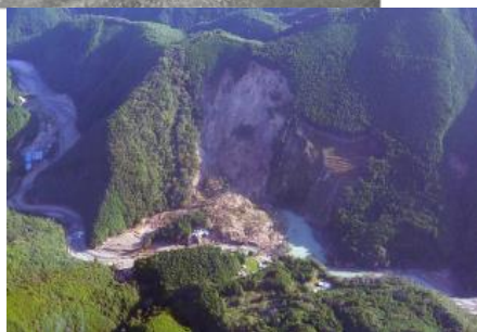
三越川砂防堰堤群（和歌山県田辺市本宮町三越）
