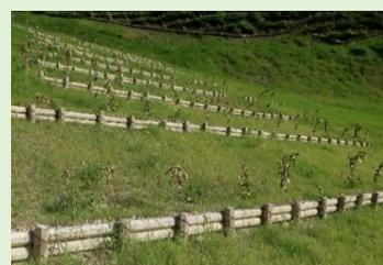
復旧工事における丸太筋工
