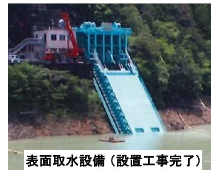
濁水対策の状況（風屋ダム）
