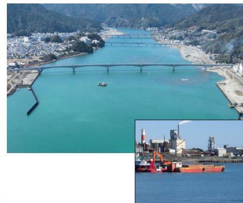
河道掘削状況（河口付近）
