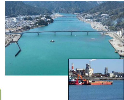
河道掘削状況(河口付近)
