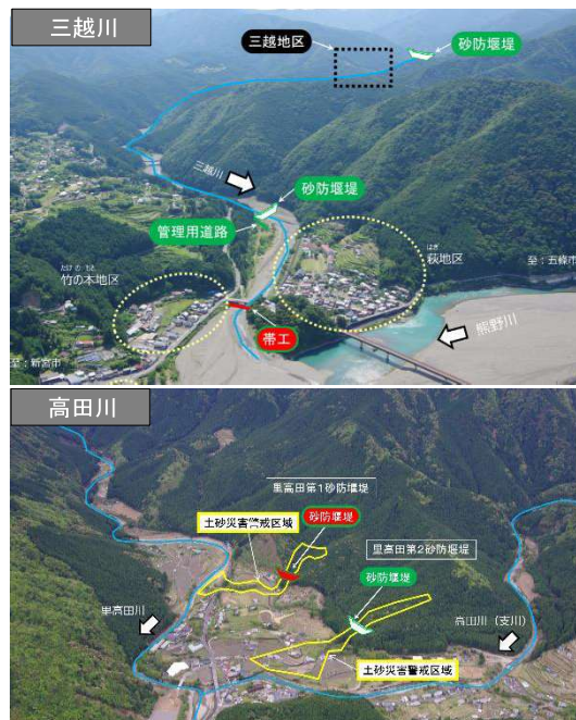
三越川と高田川の土砂流出対策
