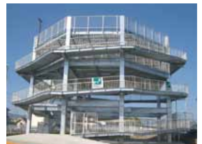
津波避難タワー
