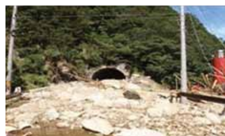
国道168号（新宮市）
