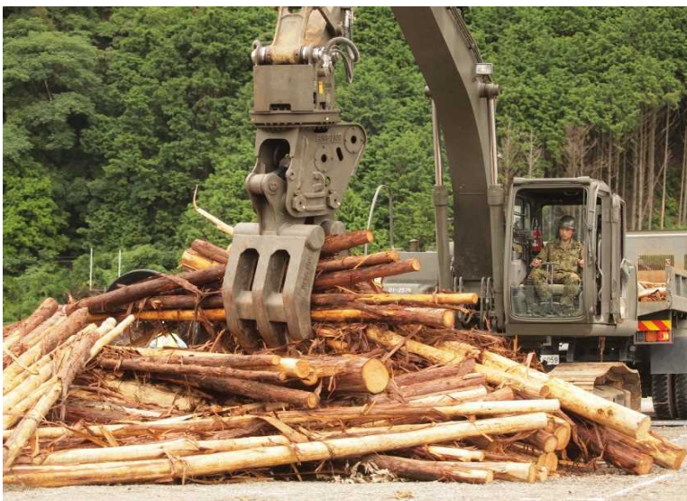
重機による流木除去状況
