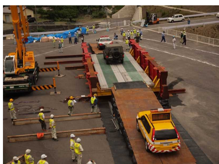
緊急仮設橋組立後の車両走行状況
