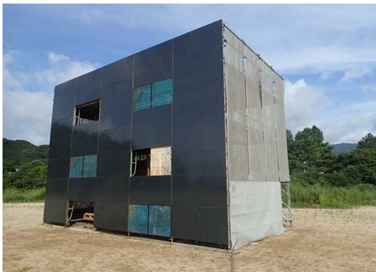
被災建物の状況（1）
