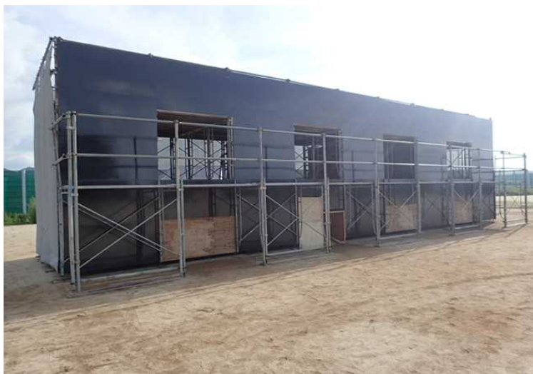
被災建物の状況（2）
