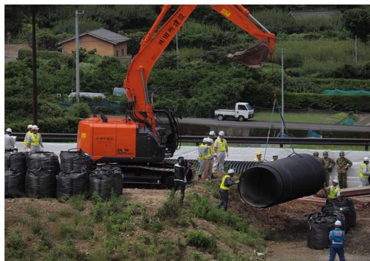
重機による土のう・コルゲート管の設置状況
