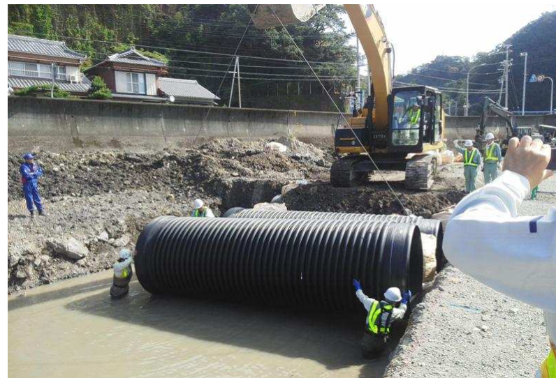
流出橋梁復旧(コルゲート管設置)
