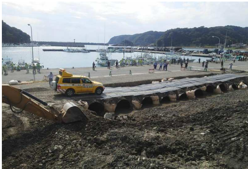
流出橋梁復旧(緊急車両走行)
