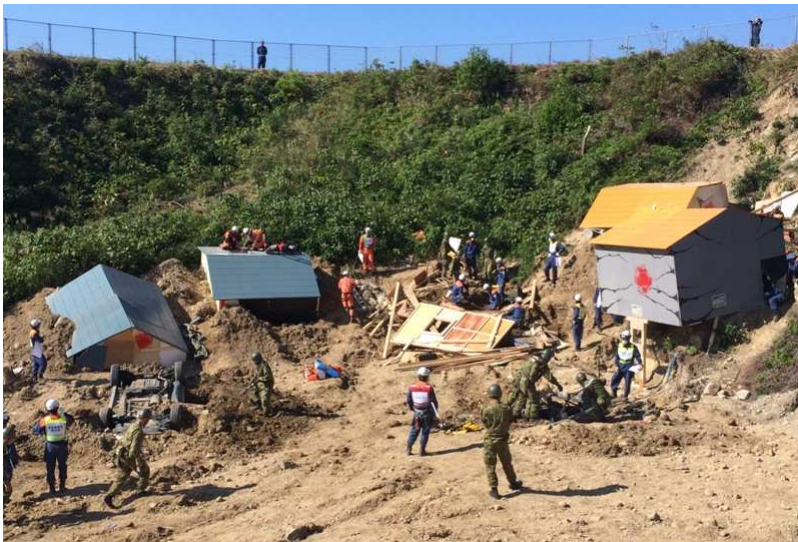
斜面崩落救出救助
