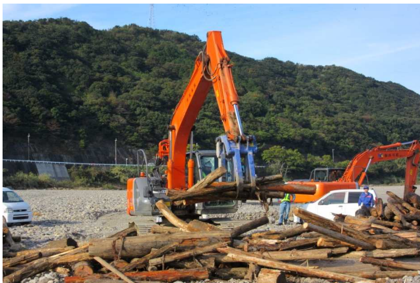
重機(バックホウ)による流木・放置車両等の除去状況
