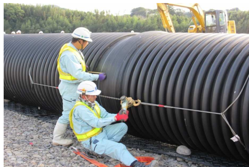
コルゲート管の設置状況
