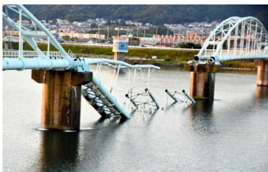
（崩落した六十谷水管橋）
