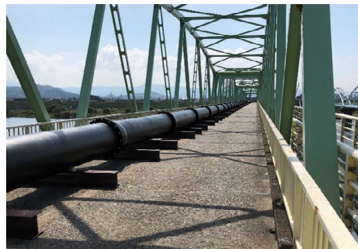
（六十谷橋に仮設された水道管）
