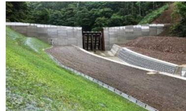
砂防堰堤による土石流対策
