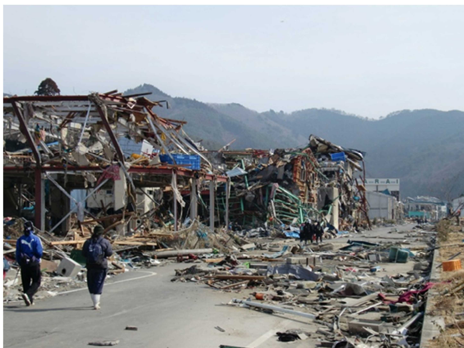
女川町宮ヶ崎地区における水産加工施設の被災状況
