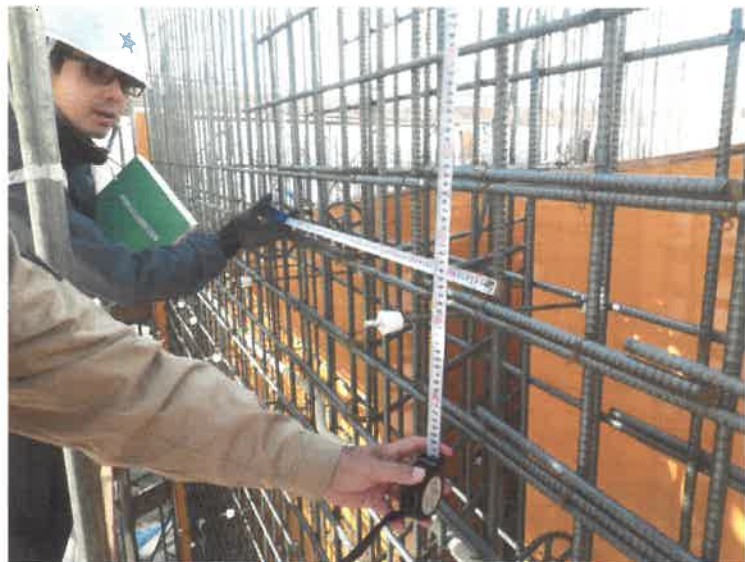
【施工】 安全で安心な建築物を作るため、適正な施工が行われているか、監理を行い、確認・承認等を行っています。
