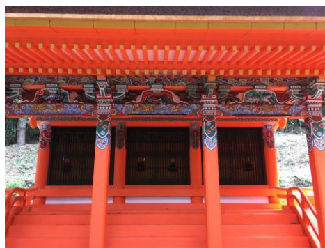
【国指定重要文化財（建造物）】 三郷八幡神社 保存修理（海南市）
