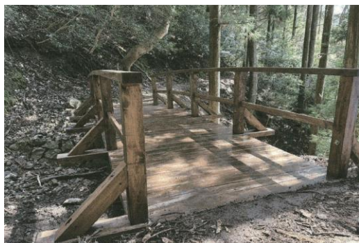
高野参詣道（町石道 17～18 町石） 木橋修繕（高野町）
