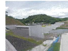
南紀田辺～すさみ間工事状況
