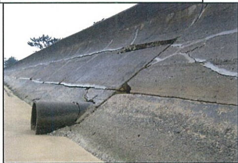
補強等の対象となる護岸 (例)
