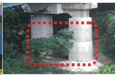
菖蒲橋 (橋脚巻立工)
