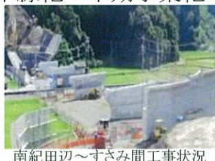
南紀田辺～すさみ間工事状況
