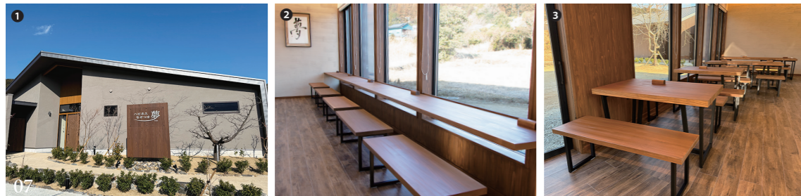
宿泊施設は床やドアなど内装にも紀州材を使用。
