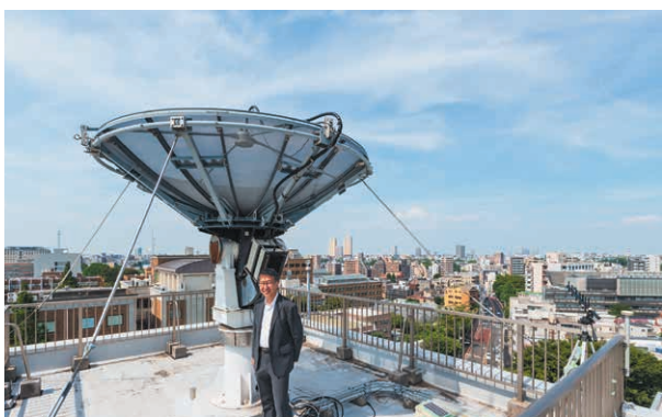
東京大学工学部研究棟屋上に設置されているパラボラアンテナ。この上空を衛星が通過する際にコマンドを送信したり、衛星の健康状態の情報や画像データを受け取る。
