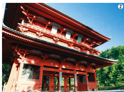
②高野山の総門である大門。現在の建物は1705年に再建されたもので、猛々しい金剛力士像が安置されている。
