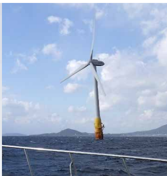
洋上風力発電設備(長崎県五島市)
