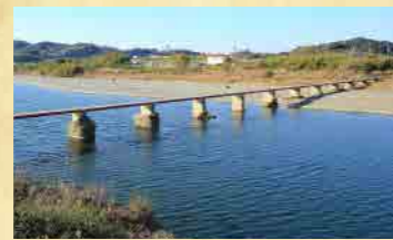
富田川の潜水橋 氾濫を繰り返してきた富田川では、洪水で破壊されない橋を架ける必要があり、水の抵抗を受けるらんかんのない潜水橋が架けられています。
