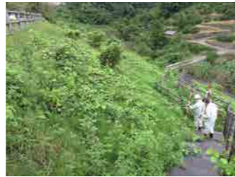
盛土の現地調査
