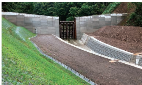
土砂災害防止施設の整備
