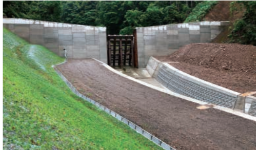
土砂災害防止施設の整備
