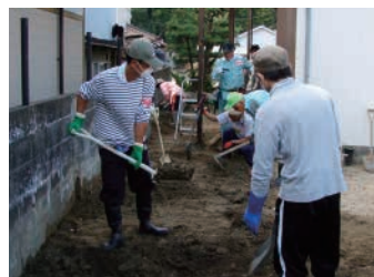
ボランティアによる泥出し
