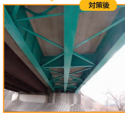
県道小豆島船所線 千手川橋(桁の塗装)
