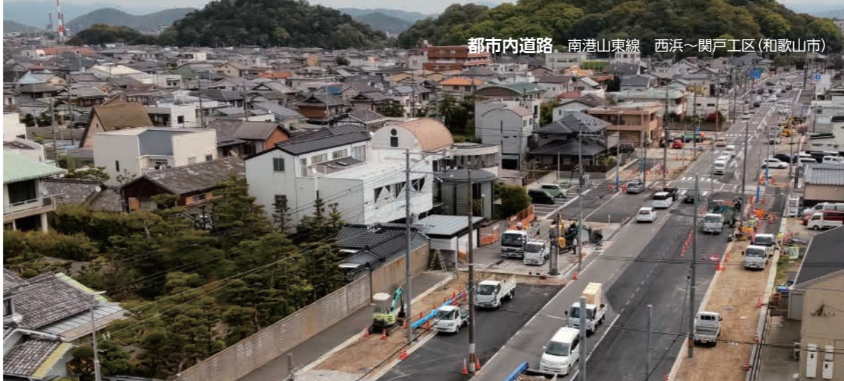
都市内道路 紀伊停車場田井ノ瀬線 南田井ノ瀬橋 小豆島～出島工区(和歌山市)
