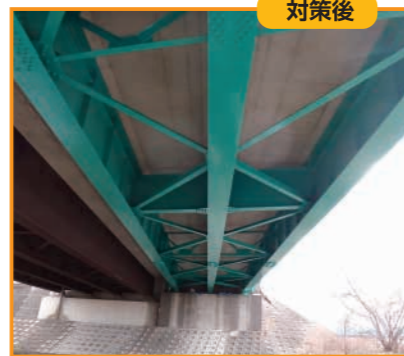
県道小豆島船所線 千手川橋(桁の塗装)
