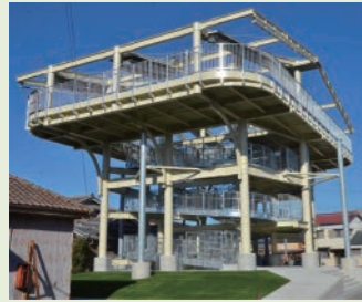
津波避難タワー
