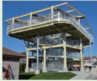
津波避難タワー
