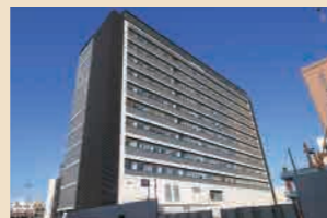
薬学部校舎(伏虎キャンパス)
