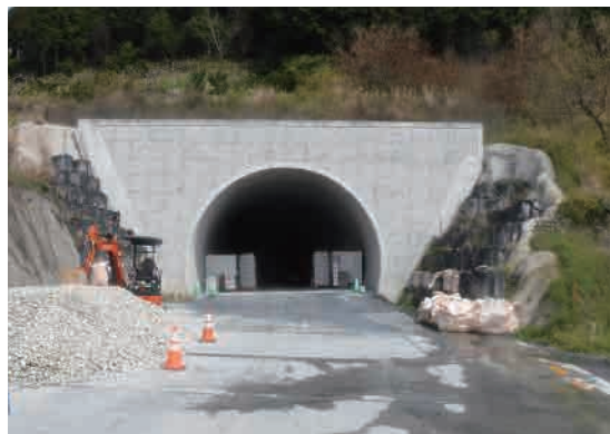
国道371号(仮称)新紀見トンネル(橋本市)
