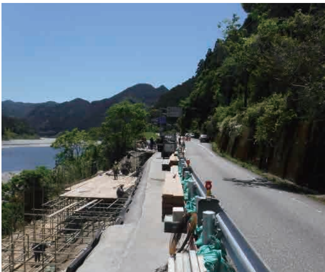
国道168号相賀高田工区(新宮市)
