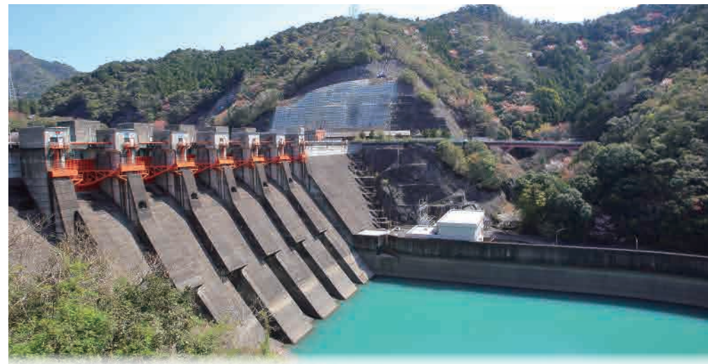
日高川 橋山ダム
