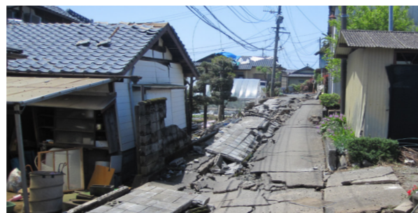
熊本地震で倒壊したブロック塀
