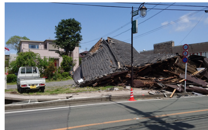
熊本地震で倒壊を免れた家屋(左)と倒壊した家屋(右)
