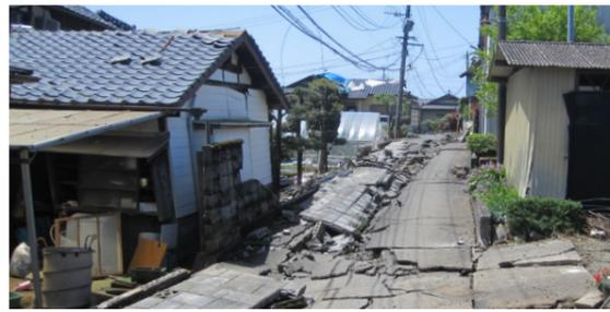
熊本地震で倒壊したブロック塀
