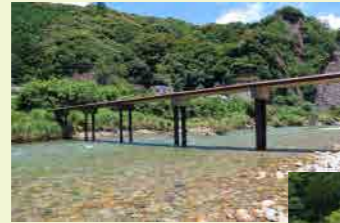
古座川の潜水橋 増水時に川の中に潜ることで、流木などによる被害を避けられるようになっているめずらしい橋です。
