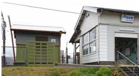
改修後のJR田並駅トイレ
