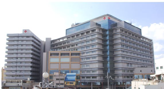
今月、本館が竣工した「日赤和歌山医療センター」
