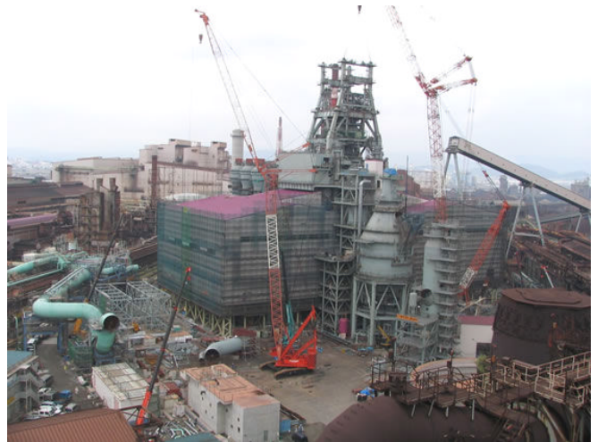
建設中の新第1高炉
