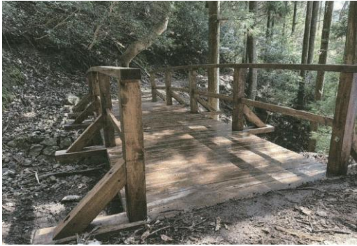
高野参詣道（町石道 17～18 町石） 木橋修繕（高野町）
