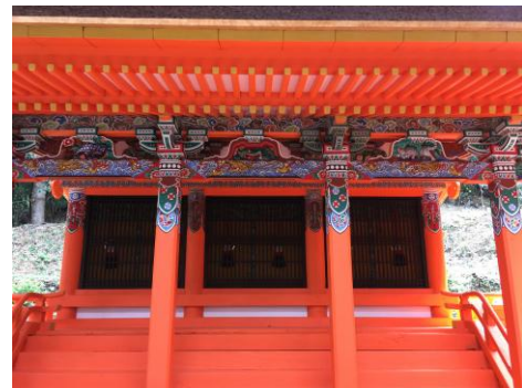
【国指定重要文化財（建造物）】 三郷八幡神社 保存修理（海南市）
