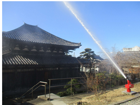
【国宝（建造物）】 善福院釈迦堂 防災施設整備（海南市）
