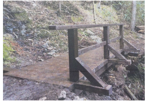
復旧後の状況
