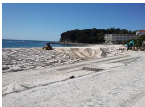
整備中の白良浜海水浴場（白浜町）
