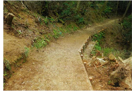
復旧後の状況
