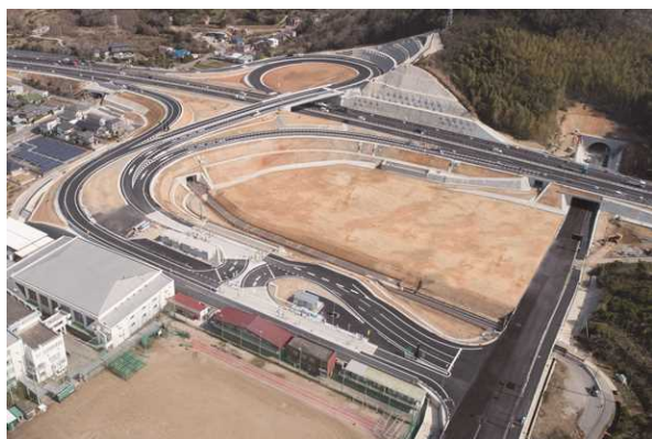
和歌山南スマートインターチェンジ全景
