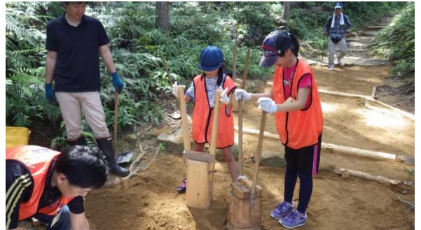
「タコ」と呼ばれる道具で土を固める様子
