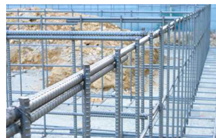
住宅基礎ユニット鉄筋
