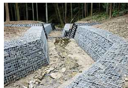
河川鋼製護岸枠
