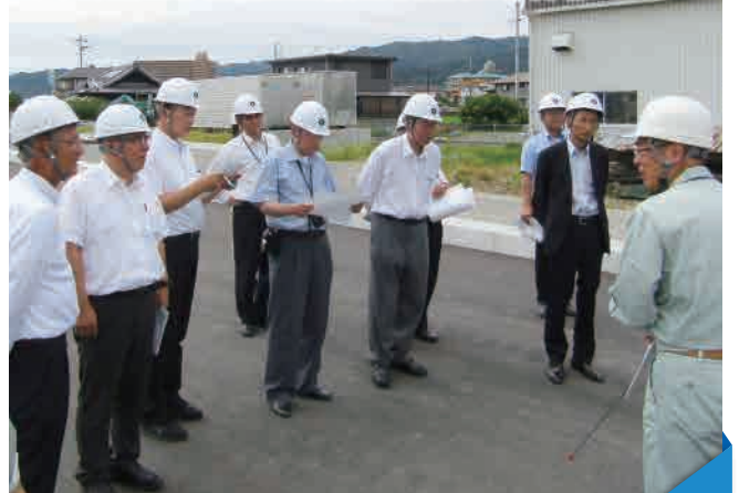
都市計画道路 西脇山口線道路新設工事現場
