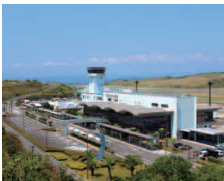
現在の南紀白浜空港ターミナルビル
