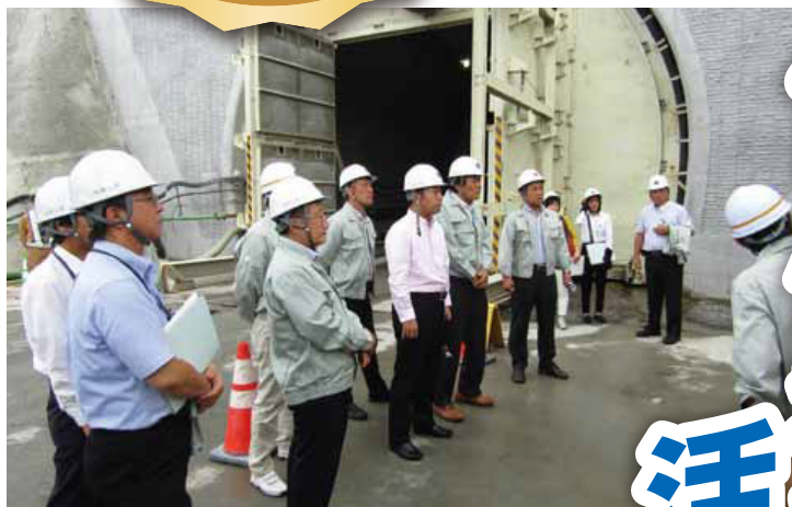
新紀見トンネル工事の状況を調査
