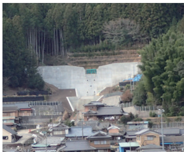
砂防ダム(日高川町皆瀬地内)
