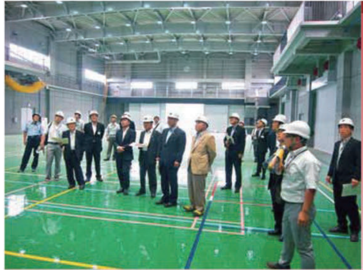
建設中の県消防学校屋内訓練場
