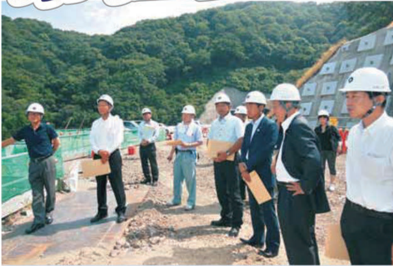
和歌山ジャンクション(仮称)の建設現場
