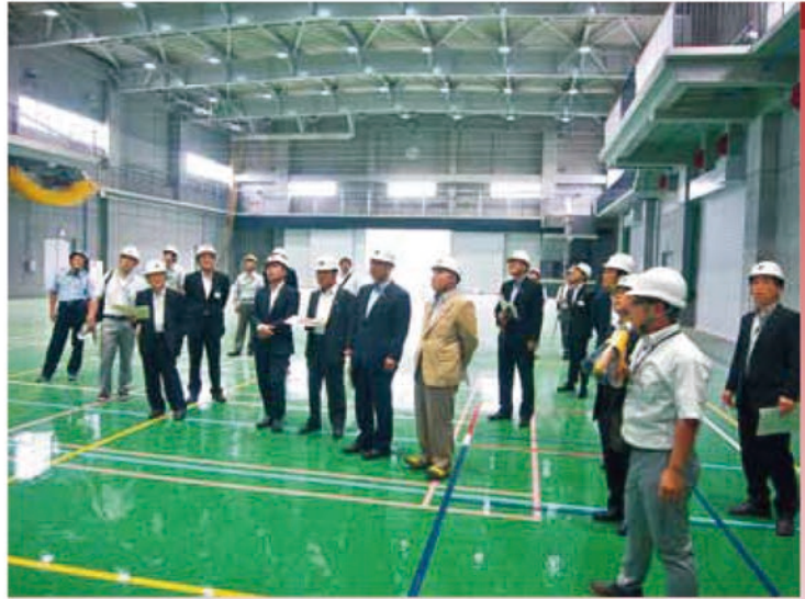
建設中の県消防学校屋内訓練場
